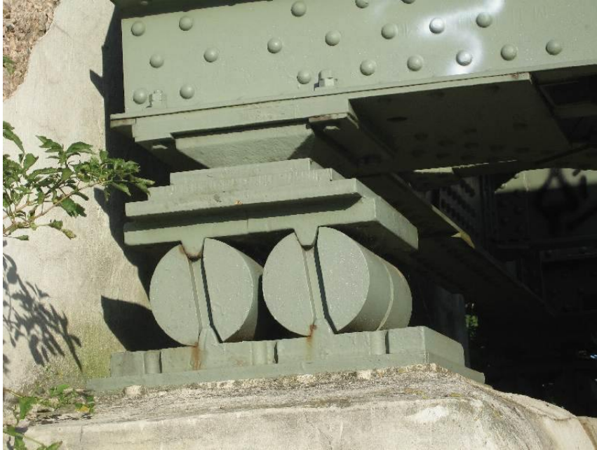
Bild 2: In Längsrichtung bewegliches Lager der gleichen Brücke. Die beiden Rollen werden über die an Lagerfußplatte (unten) und Lagerkopfplatte (oben) angegossenen Nocken gehalten. Da im Modellbau zu aufwendig, wurde für das Brückensystem eine Konstruktion gewählt, bei der die Halter an den Rollen befestigt sind und in Aussparungen in Lagerfußplatte und Lagerkopfplatte greifen.
