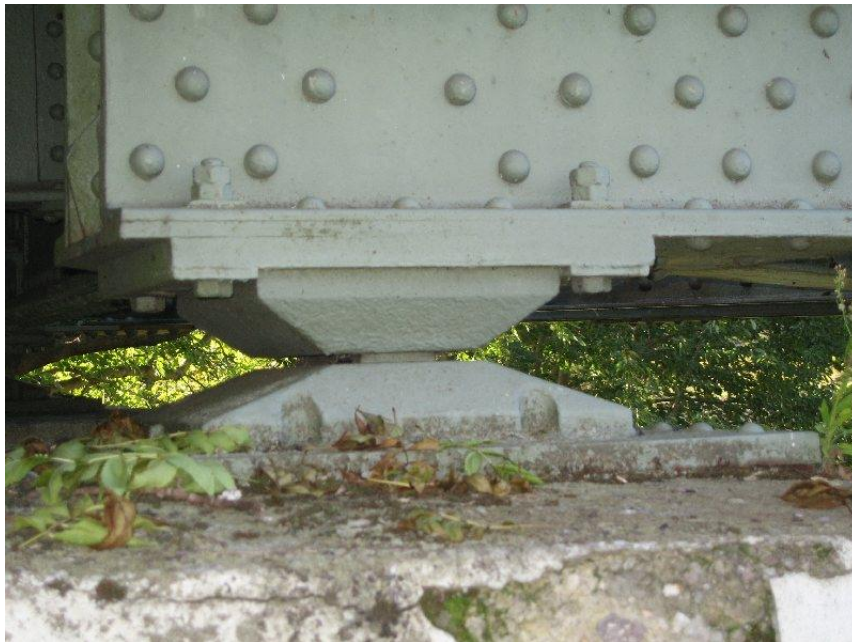
Bild 1: Festes Lager einer genieteten Stahlbrücke. Das Teil, welches zwischen den beiden konischen Gussteilen (Lagerkopfplatte unten und Lagerfußplatte oben) sichtbar ist, entspricht der im Brückensystem verwendeten Zentrierleiste.
