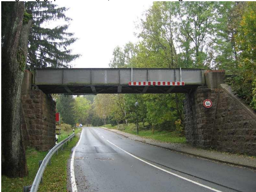
Bild 3: Vergleichbare Brücke mit durchgehendem Schotterbett der schmalspurigen Harzquerbahn in Elend. Der genietet Überbau könnte bei einer Erneuerung durch ein dem Brückensystem analoges Vorbild ersetzt werden bzw. in der Vergangenheit worden sein.
